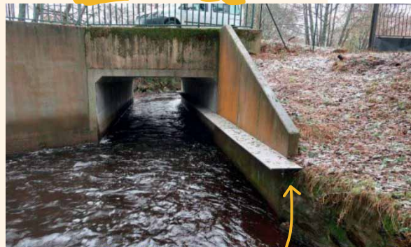
Aménagement d'un passage pour la Loutre d'Europe, de type encorbellement à Saint-Agnan (58).
