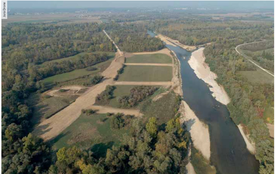
Figure 14. Vue octobre 2018 après travaux.
