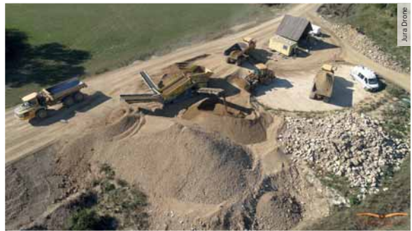
Figure 11. Criblage des matériaux.
