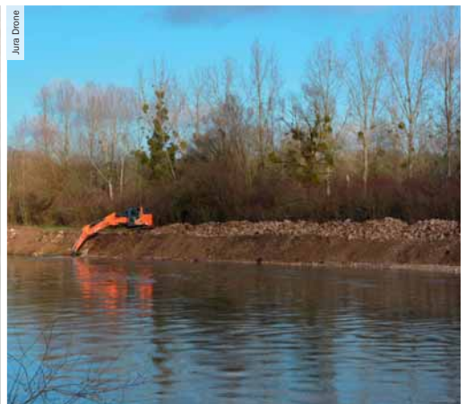
Figure 8. Désenrochement rive gauche du Doubs.
