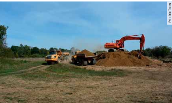
Figure 10. Démontage de la digue d'entonnement.
