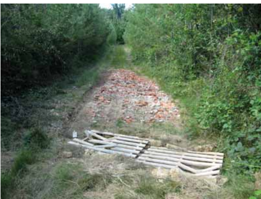
Empierrement d'une ornière. Toury-Lurcy, Nièvre, 17 juillet 2007.
